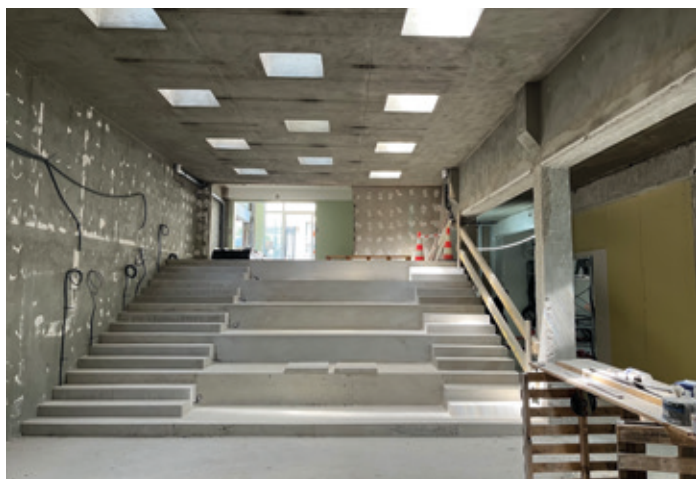
Les gradins créés en regard du rez-de-jardin.
