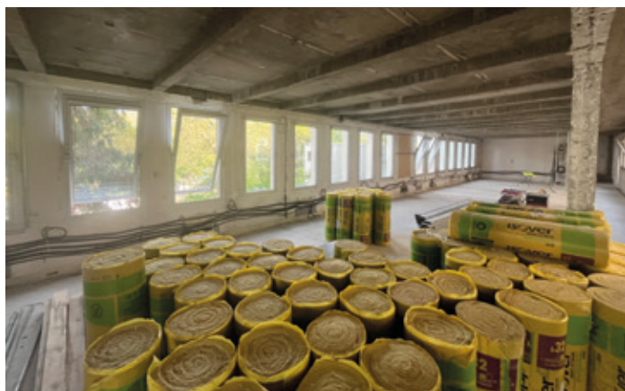
Un gros travail d'isolation est actuellement en cours.
