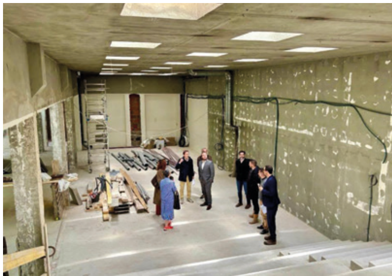
Visite de chantier effectuée par le Maire, Julien Weil et Jacques Guionet en présence de l'architecte, Antonio Virga.
