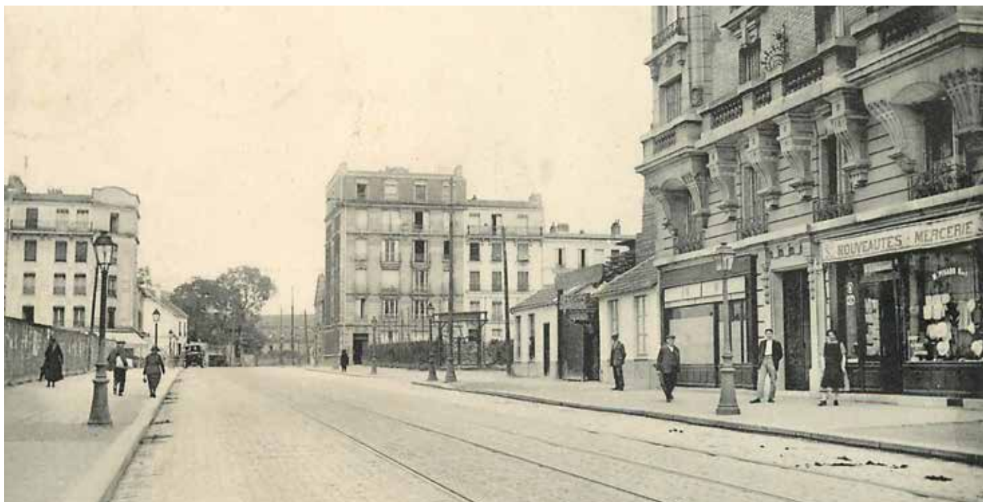
Percement entre la rue de l'Épinette et l'avenue Daumesnil.
