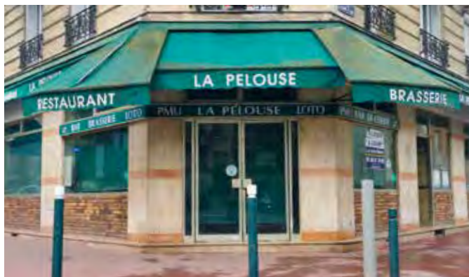
La Pelouse avant travaux.
