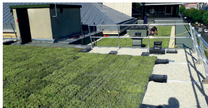
Isolation et végétalisation de la toiture du Centre culturel.
