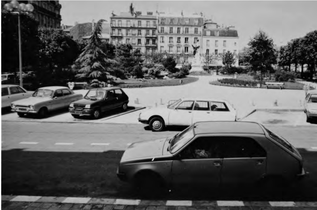
La place Charles Digeon avant les travaux de réaménagement.
