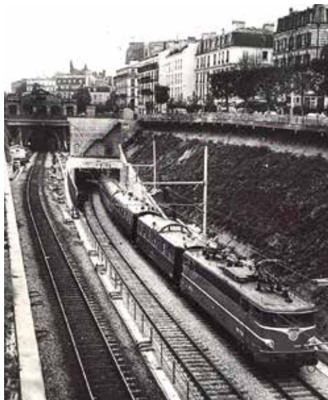
Les voies en contrebas, dans une tranchée au débouché du tunnel.
