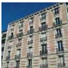
Maçonneries mixtes de briques et pierre de taille.
