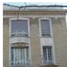
Maçonneries mixtes de briques et éléments de ciment.
