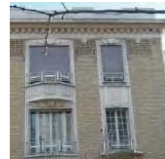
Maçonneries mixtes de briques et éléments de ciment.
